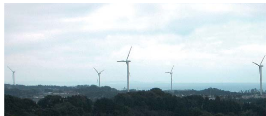
佐賀県某風力発電所
