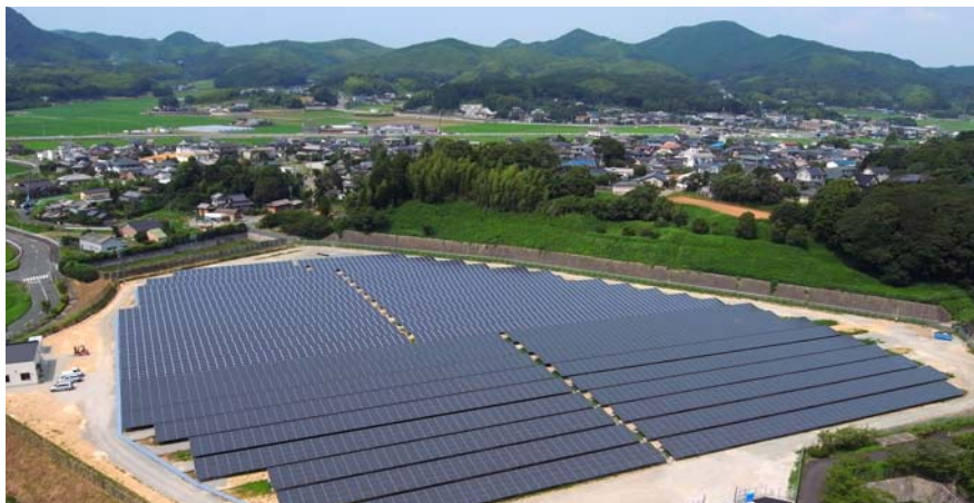
福岡県某太陽光発電所
